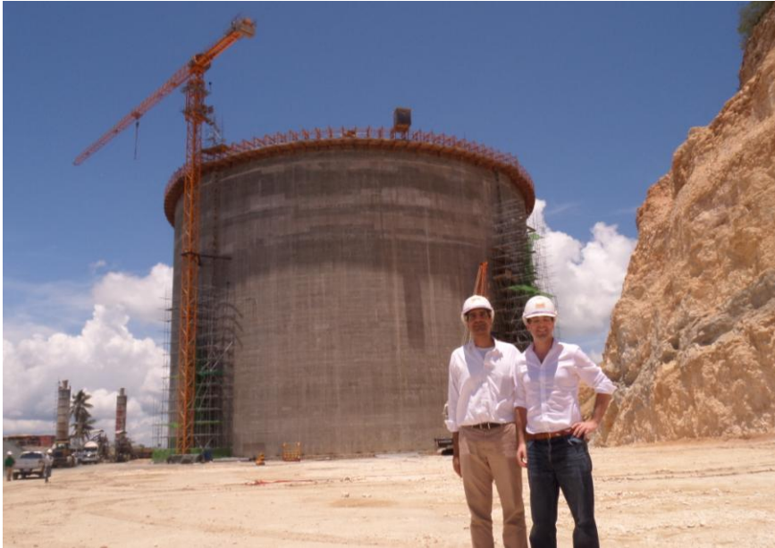
Pagbilao LNG Storage Tank
