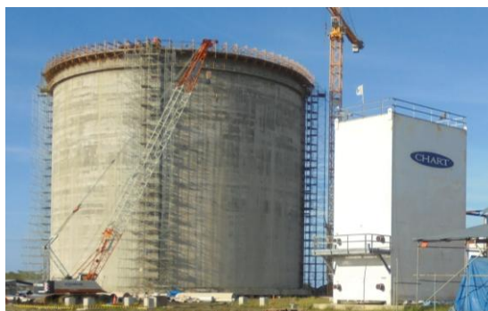
LNG Tank and Cold Box
