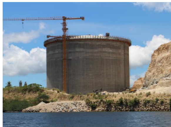
LNG Storage Tank
