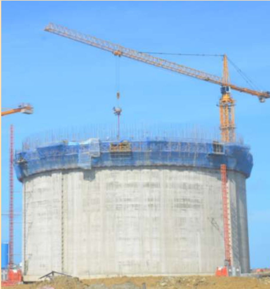
LNG Tank in July 2014
