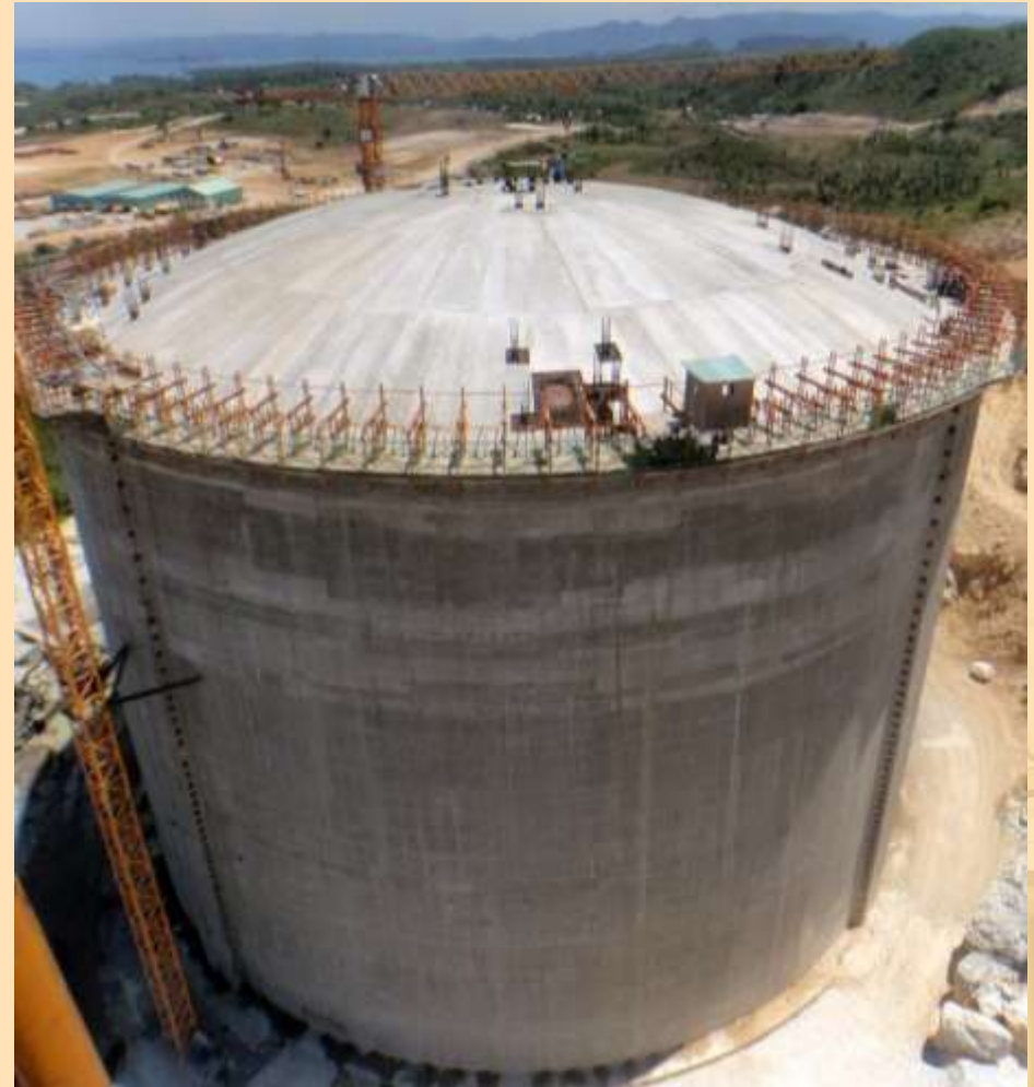
LNG Tank in May 2015
