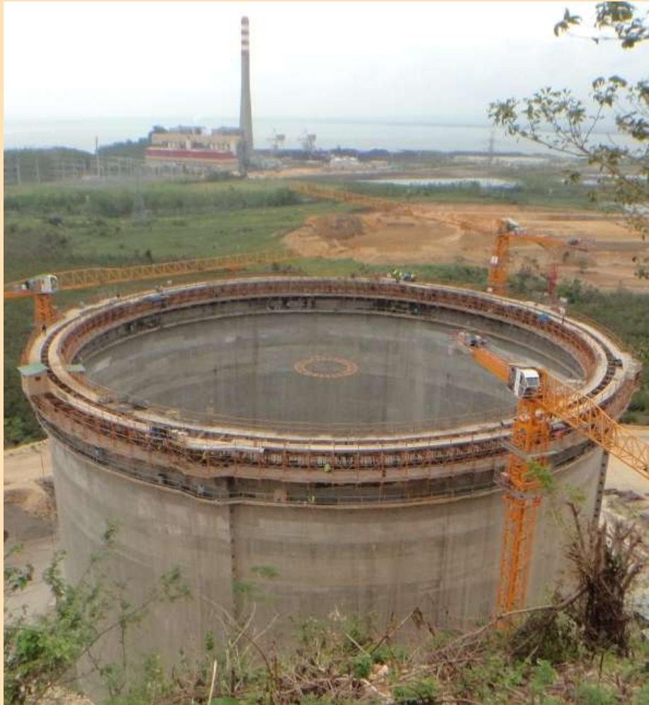
LNG Tank in July 2014
