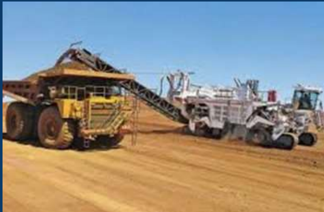
Wirtgen 4200 Direct Loading
