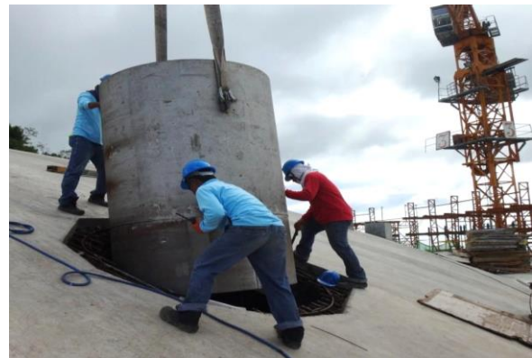
Construction of LNG Tank Roof
