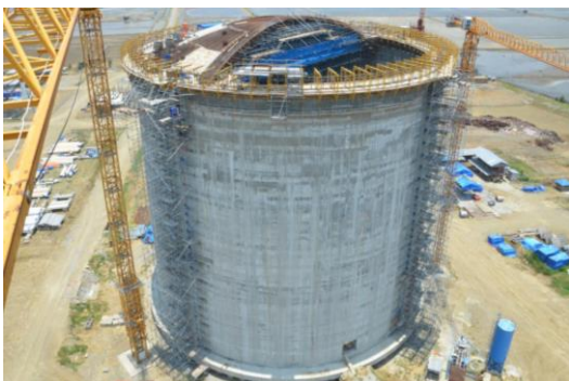
Construction of the LNG Tank
