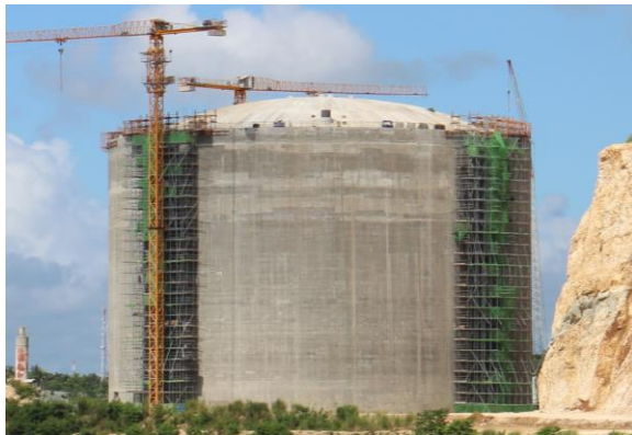
Construction of LNG Tank
