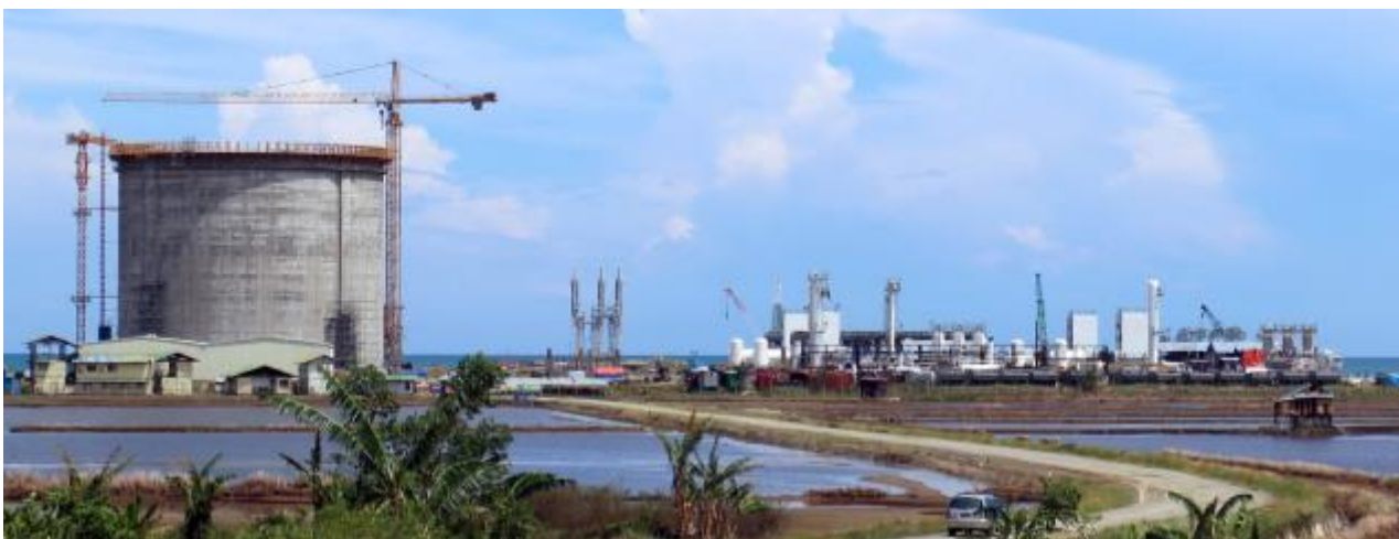
Sengkang LNG Plant Project
