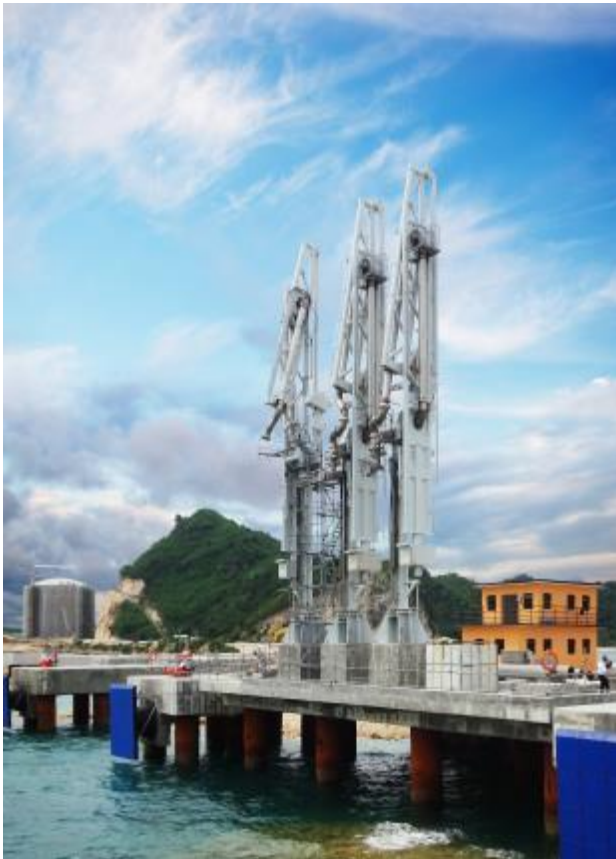
Erection of LNG Loading Arms
