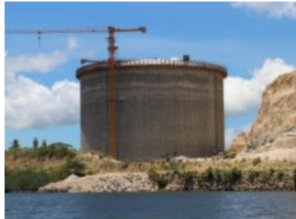
LNG Storage Tank
