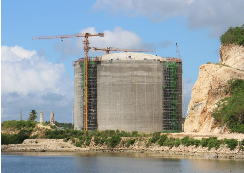
Pagbilao LNG Storage Tank
