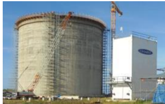
LNG Tank and Cold Box
