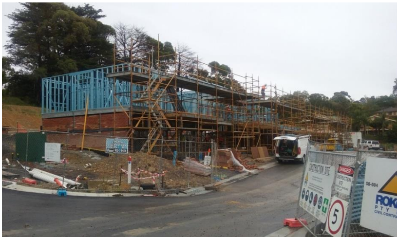
Mingarra construction site
